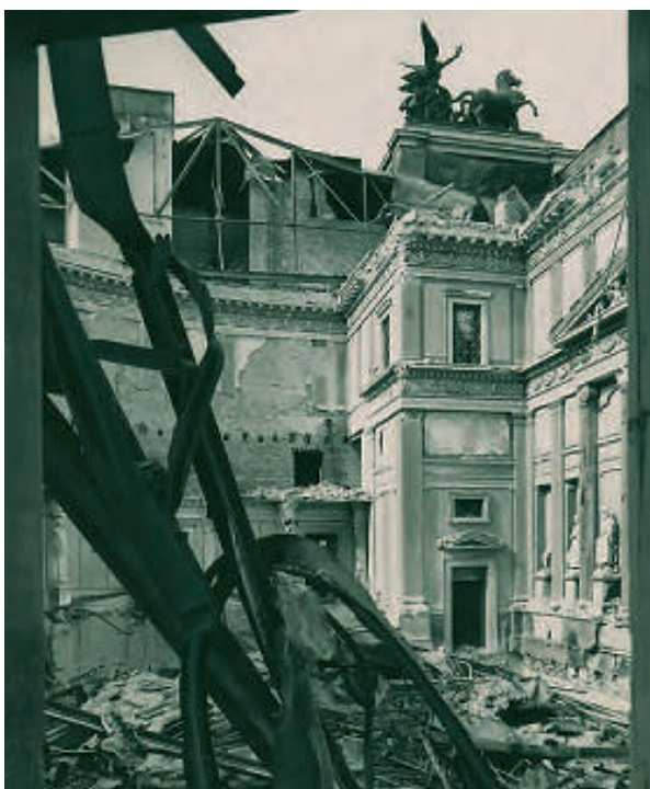
Das zerstörte Parlamentsgebäude, 1945
